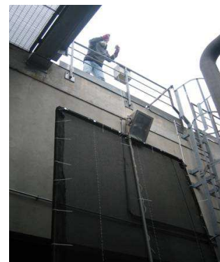
Hissage d'une toile sur le toit
