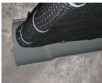
Détail gouttière de récupération
